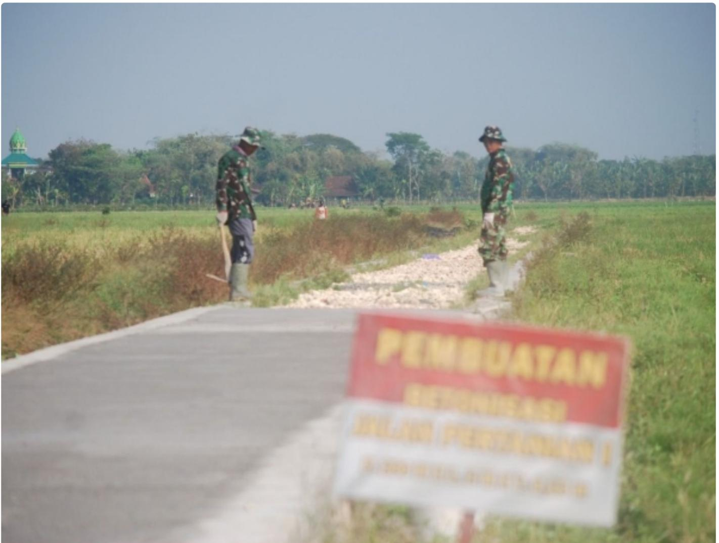
*Tentara Nasional Indonesia (TNI) Membantu Pembangunan Jalan Pertanian Sepanjang 200 Meter Lebar 2 Meter Dan Tebal 0.15 Meter. Ini Merupakan Sasaran ke-2 Pengecoran Jalan Oleh Satgas TMMMD Reguler ke 114 Kodim 0716/Demak*
