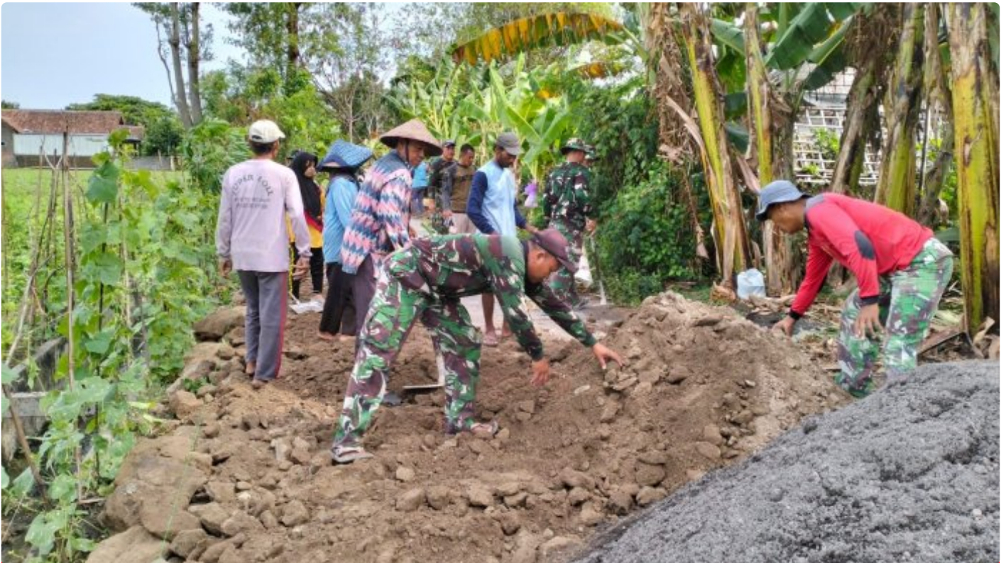
Peduli Jalan Rusak Di Wilayah Binaan, Babinsa Bersama Warga Karya Bakti Timbun Jalan.
