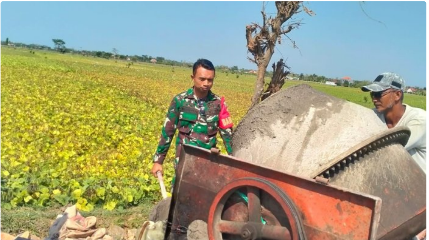
TNI Selalu Hadir Ditengah Rakyat, Babinsa Bantu Warga Buat Talud
